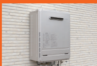
ガス給湯器の交換
